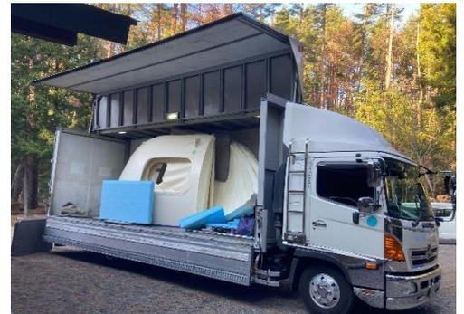
膨らませる、吹き付ける、分割する、組み立てるといったシンプルな工法により「施工～移設～組み立て」までの一連作業が約 3 日間、現地での作業時間は 1~2 時間で完成します。ドーム型の生地を固定し、送風機で中に空気を入れて生地を大きく膨らませ、内側から断熱性のあるウレタン材を吹き付けます。生地と吹き付けたウレタン材が定着したハウスを分割し、パーツを施工場所へ移送します。分割パーツによる組み立て方式を採用することで、狭いスペースでも柔軟に設置や移動することが可能です。
